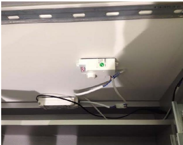
Plassering av sensor og transformator. Disse monteres i bakkant av skuffene, inne i baderommøbelet
